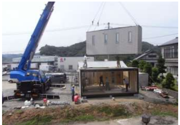
連絡所の隣に住宅ユニット資材をクレーンで設置
